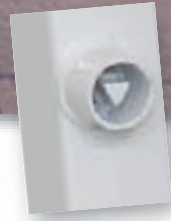
Dreikantverschluss nach DIN 3223
