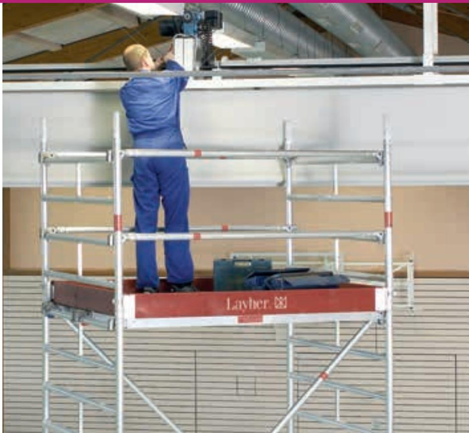
**Das Universalgerüst Uni Kompakt P2 mit dem doppelt breiten Arbeitsboden und dennoch kompakten Grundmaßen – bietet ausreichenden Arbeitsplatz in der Höhe auch für Arbeiten mit Material und dennoch üppiger Bewegungsfreiheit.**
