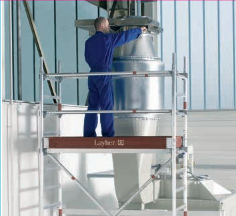
**Das Uni Leicht Gerüst P2 ist ein kompaktes, leichtes Fahrgerüst für sicheres und bequemes Arbeiten überall dort, wo Sie bisher auf der Leiter standen – die Standfläche von immerhin 1,3 m<sup>2</sup> erlaubt ungehindertes Bewegen und die Mitnahme von Werkzeug und Material.**
